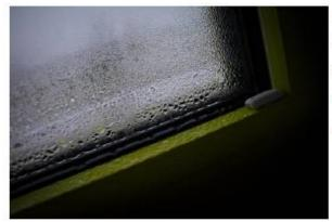
Nicht ausreichend beseitigte Feuchtigkeit in den Räumen kann zu Schimmelbildung führen und die Bausubstanz angreifen, indem das Kondensat immer tiefer in die Wände eindringt.
